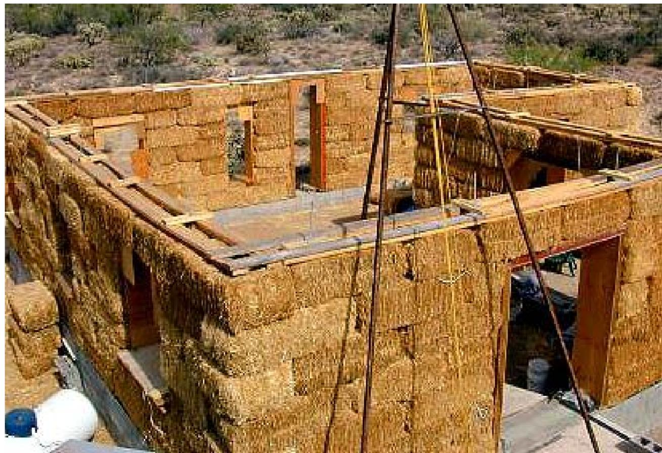
En la unión entre el zócalo de piedra, el bastidor de madera y la primera hilada de fardos se colocará una malla metálica para mejorar la adherencia de los posteriores revoques y evitar la aparición de fisuras.
